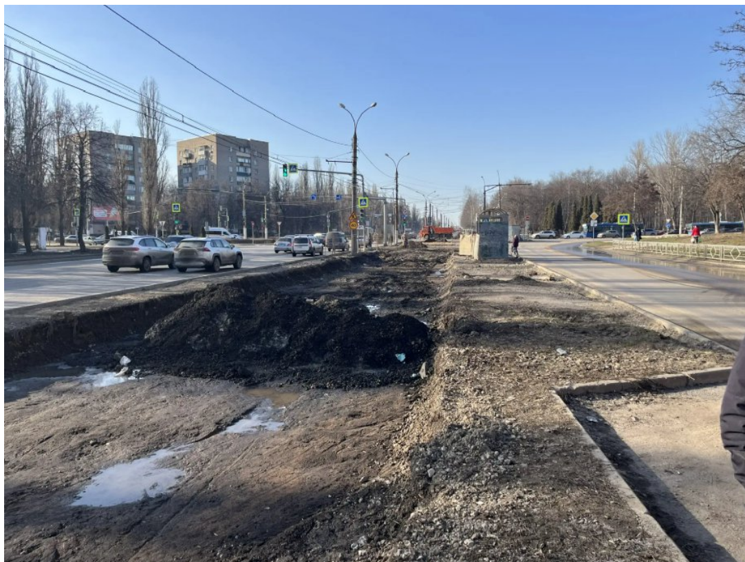
Рис.123. Улица Циолковского. Разработка котлована.
