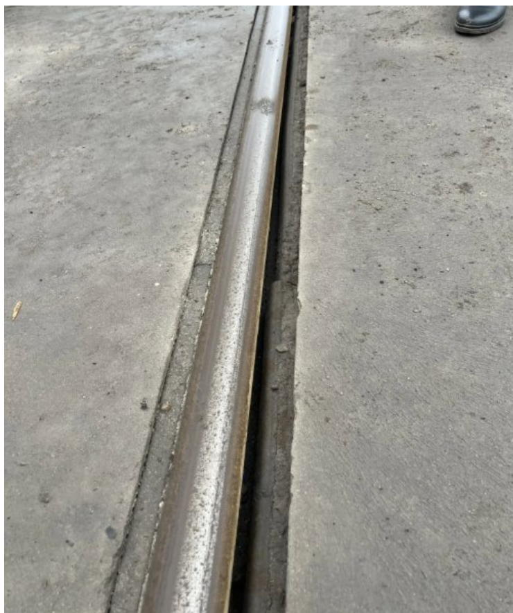
Рис.154. Остановочный пункт «Село Сырское». Продавливание резинового уплотнителя под железобетонные плиты.
