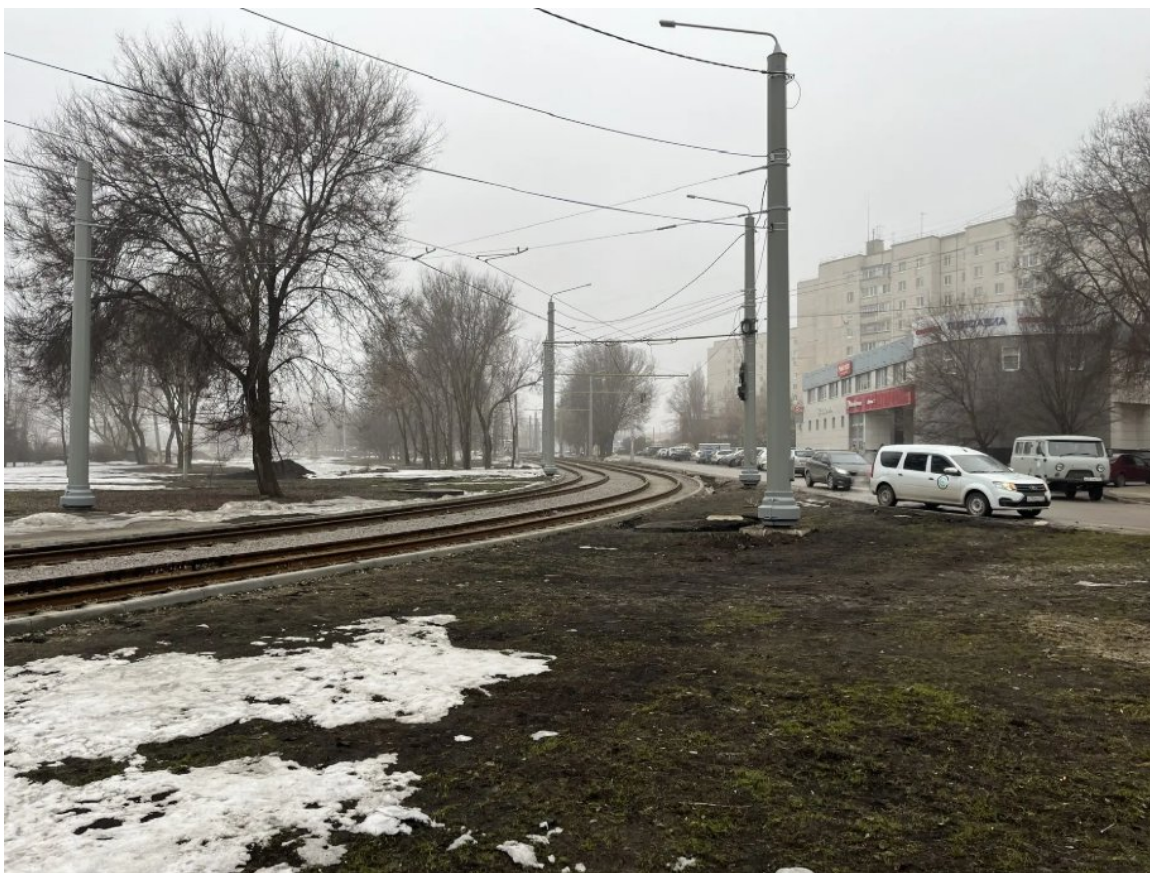
Рис.163. Трамвайные пути в районе кольца 21-го микрорайона.
