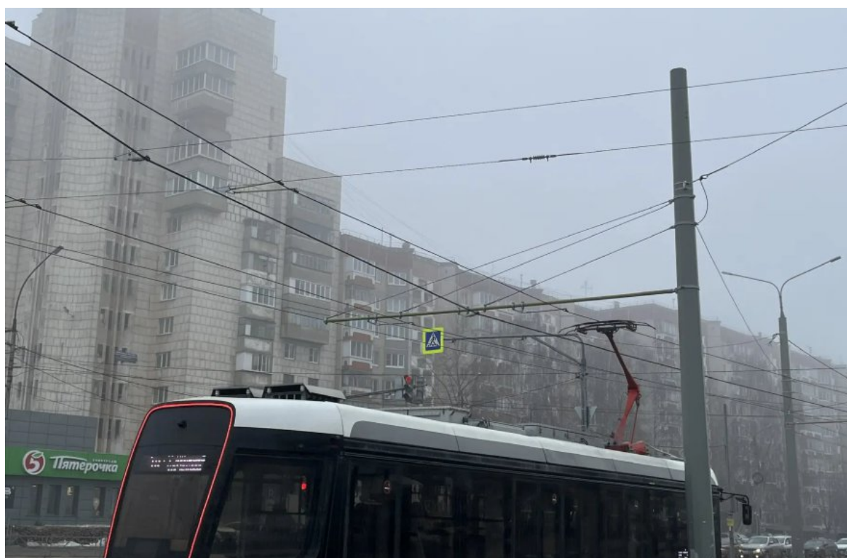
Рис. 65. На пересечении ул. Меркулова с пр. имени 60-летия СССР высота подвеса контактного провода относительно кронштейна визуальнo не соответствует СП 98.13330.2018.
