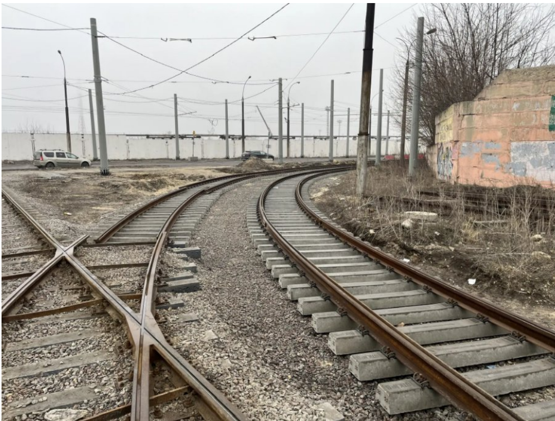
Рис. 49. Участок работ в районе пересечения ул. Краснозаводская с ул. Metallургов.
