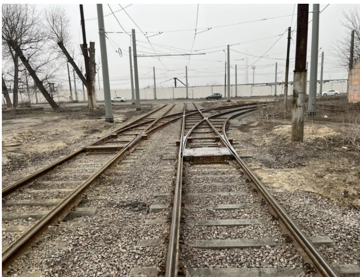
Рис. 46. Общий вид стрелочного перевода ул. Краснозаводская.
