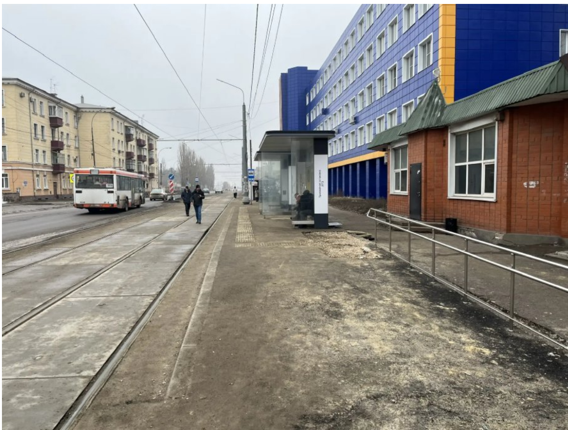
Рис. 35. Текущее состояние остановочного пункта «ЛТЗ»
