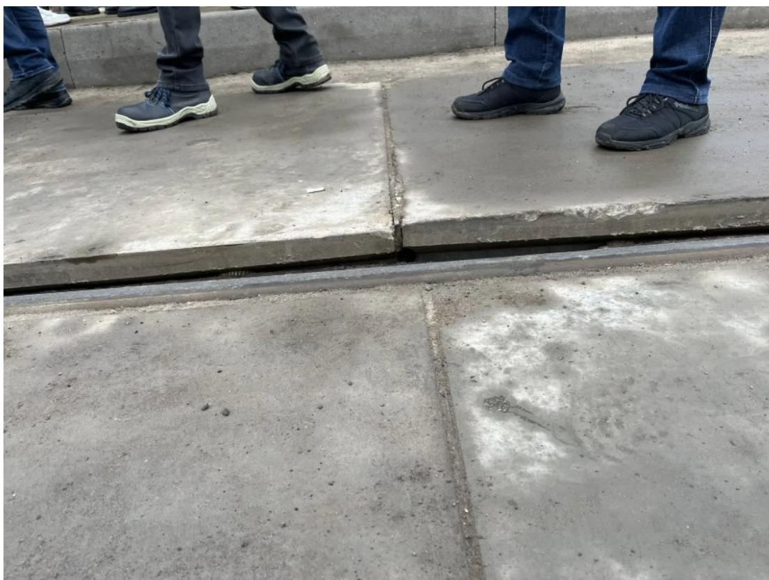
Рис. 39. Остановочный пункт «ЛТЗ» подъем железобетонных плит выше головки рельса.
