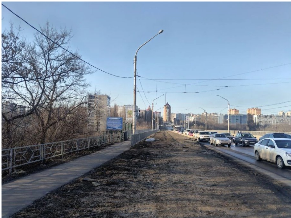
Рис.130. Мост по ул. Терешковой.
