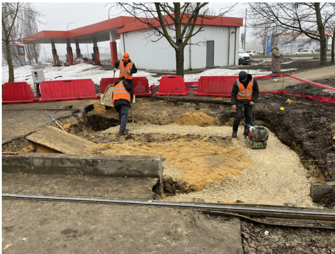
Рис. 56. Устранение просадки грунта в районе посадочной площадки остановочного пункта «21 микрорайон».
