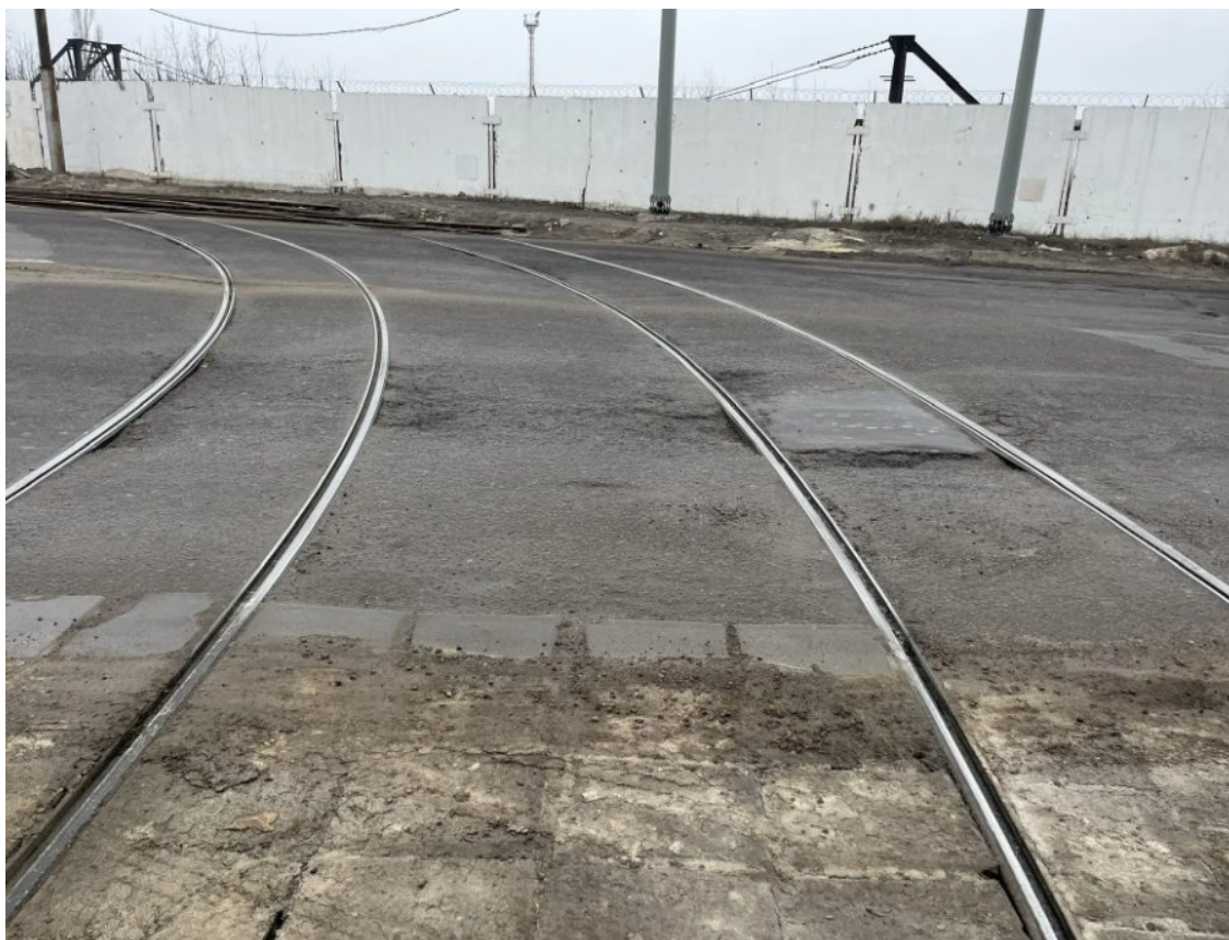
Рис. 47. Переезд в районе пересечения ул. Краснозаводская с ул. Metallургов.
