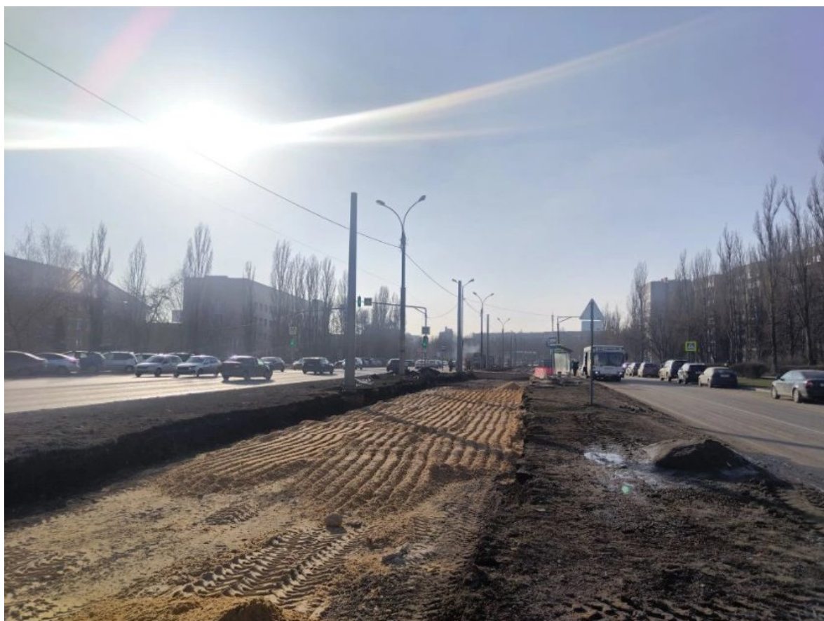
Рис. 126. Ул. Циолковского. Подготовка основания пути.
