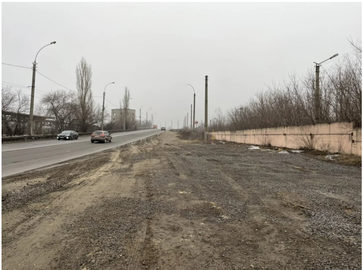
Рис.136. Трамвайные пути ул. Metallургов. Подход к путепроводу «Западный»
