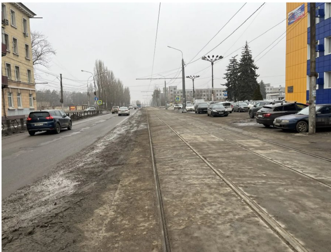
Рис. 41. Общий вид трамвайной инфраструктуры по ул. Краснозаводская в районе проходных ЛТЗ.
