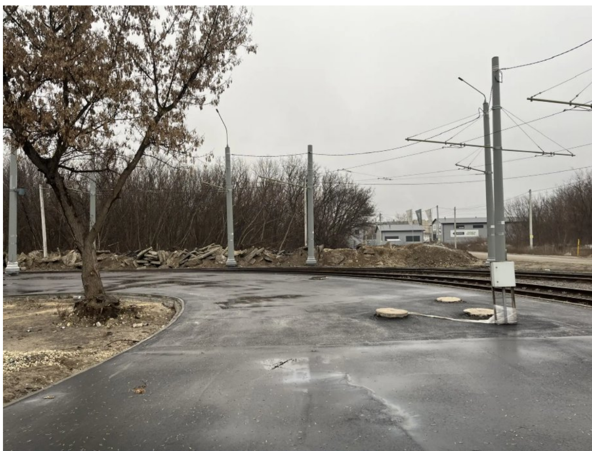
Рис. 12. Реконструкция трамвайных путей в районе ул. Чехова
