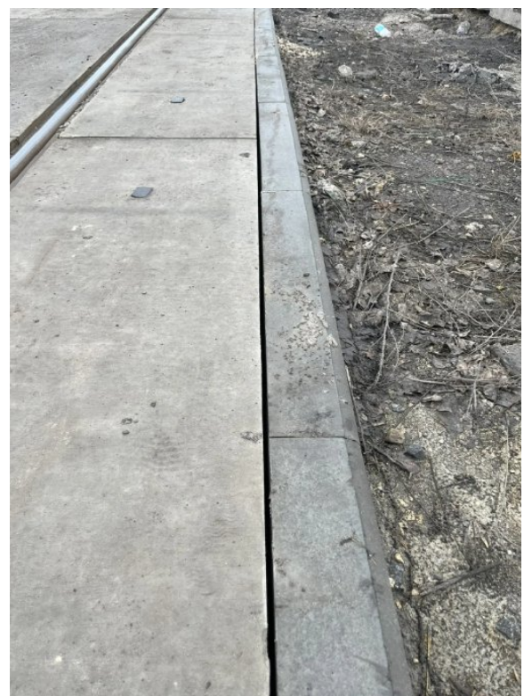
Рис.149. Остановочный пункт «ул. Речная» неплотное примыкание бортовых камней к краевой плите.
