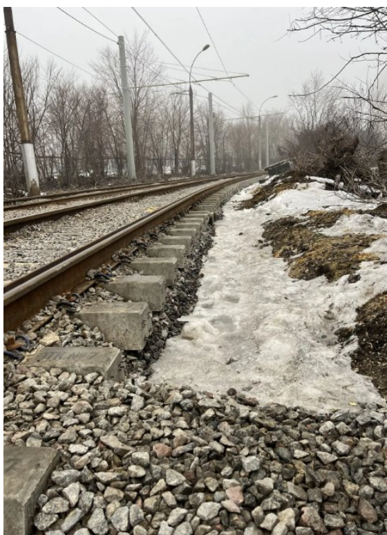
Рис.158. Подход к проспекту Победы со стороны остановочного пункта «Село Сырское». Отсутствует балластный слой в торцах шпал, не установлен бортовой камень.
