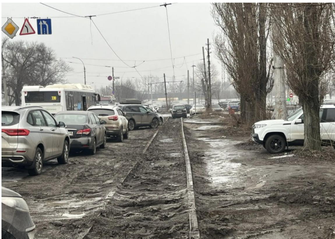
Рис.143. Ул. 9 Мая. Демонтажные работы на момент проведения Проверки не начаты.
