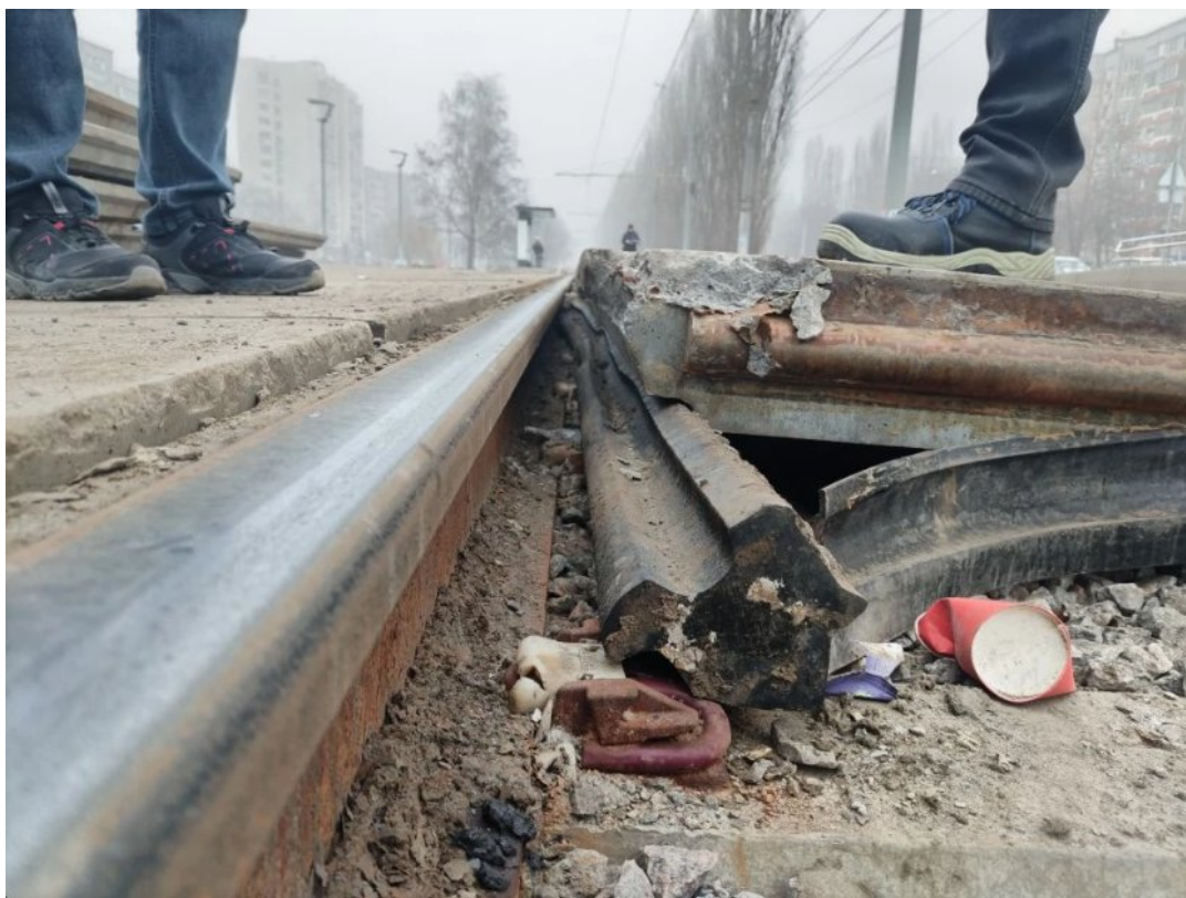
Рис. 77. Подъем железобетонных плит выше головки рельса в районе остановочного пункта «Березовая аллея».
