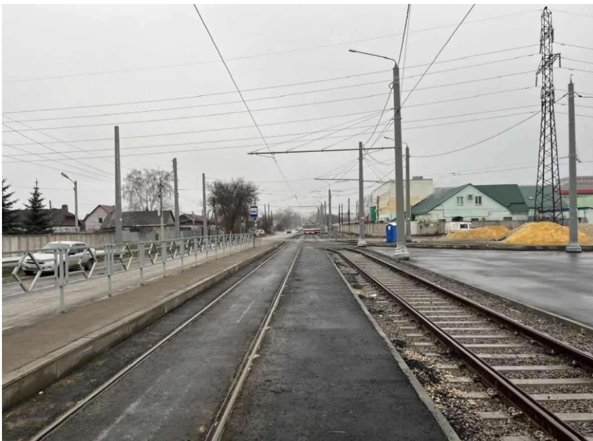
Рис. 15. Обустройство посадочной платформы в районе ул. Чехова.
