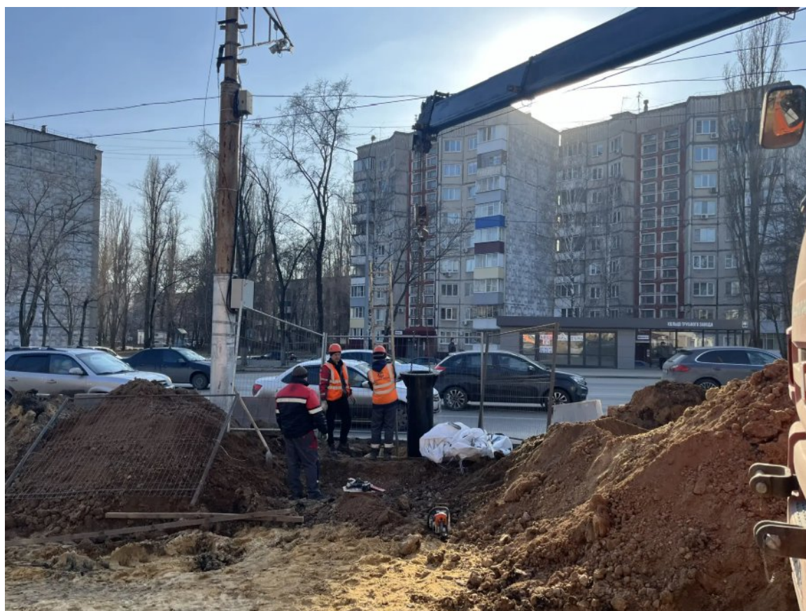
Рис.121. Улица Циолковского. Монтаж закладных деталей опор контактной сети.
