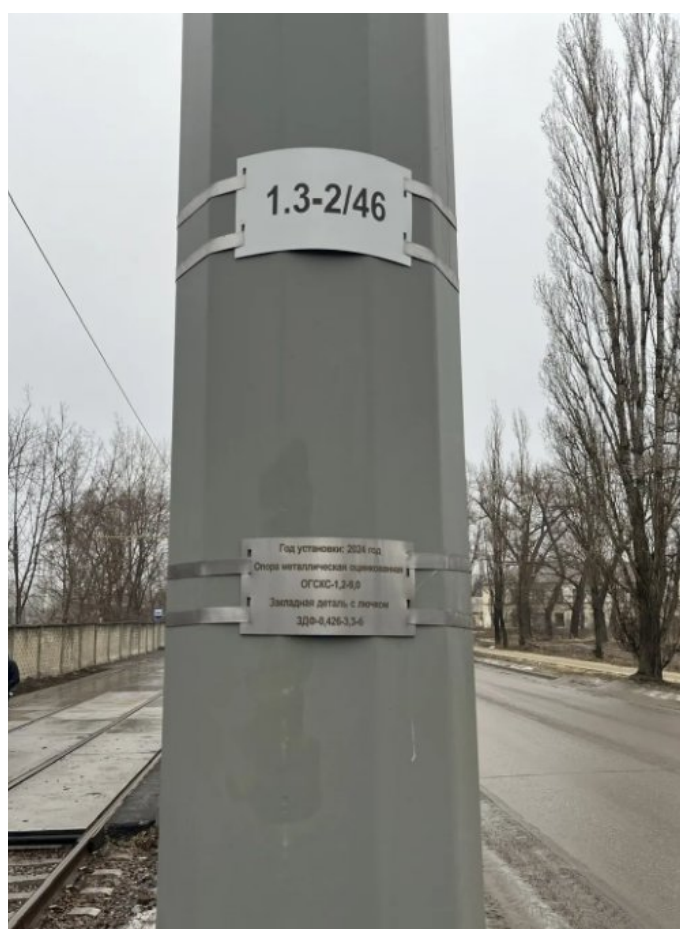
Рис. 24. Установлены бирки с нумерацией опор контактной сети.
