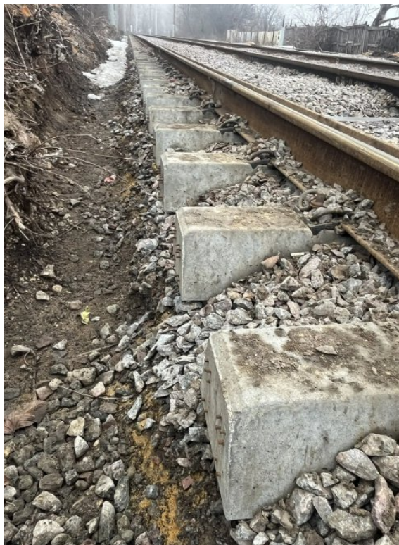
Рис.158. Подход к проспекту Победы со стороны остановочного пункта «Село Сырское». Отсутствует балластный слой в торцах шпал, не установлен бортовой камень.
