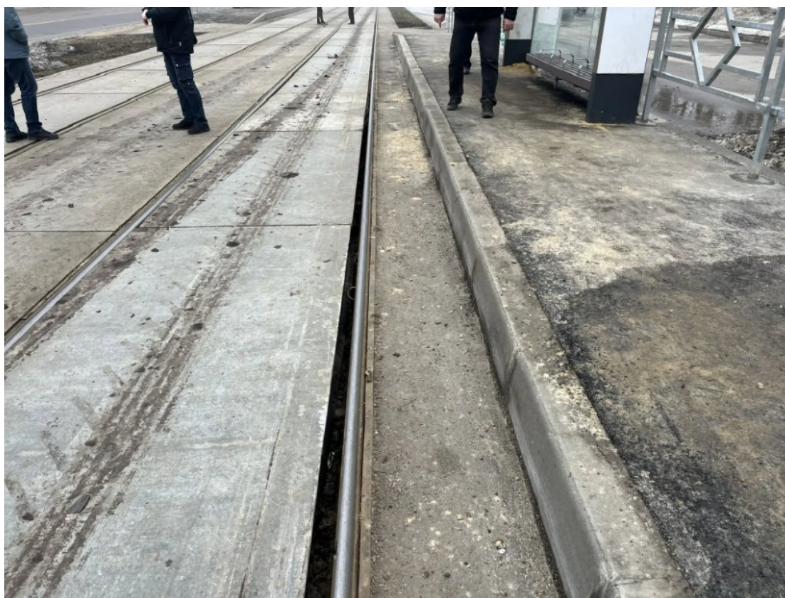
Рис. 92. Остановочный пункт «Парк Победы». Продавливание резинового уплотнителя под железобетонные плиты.
