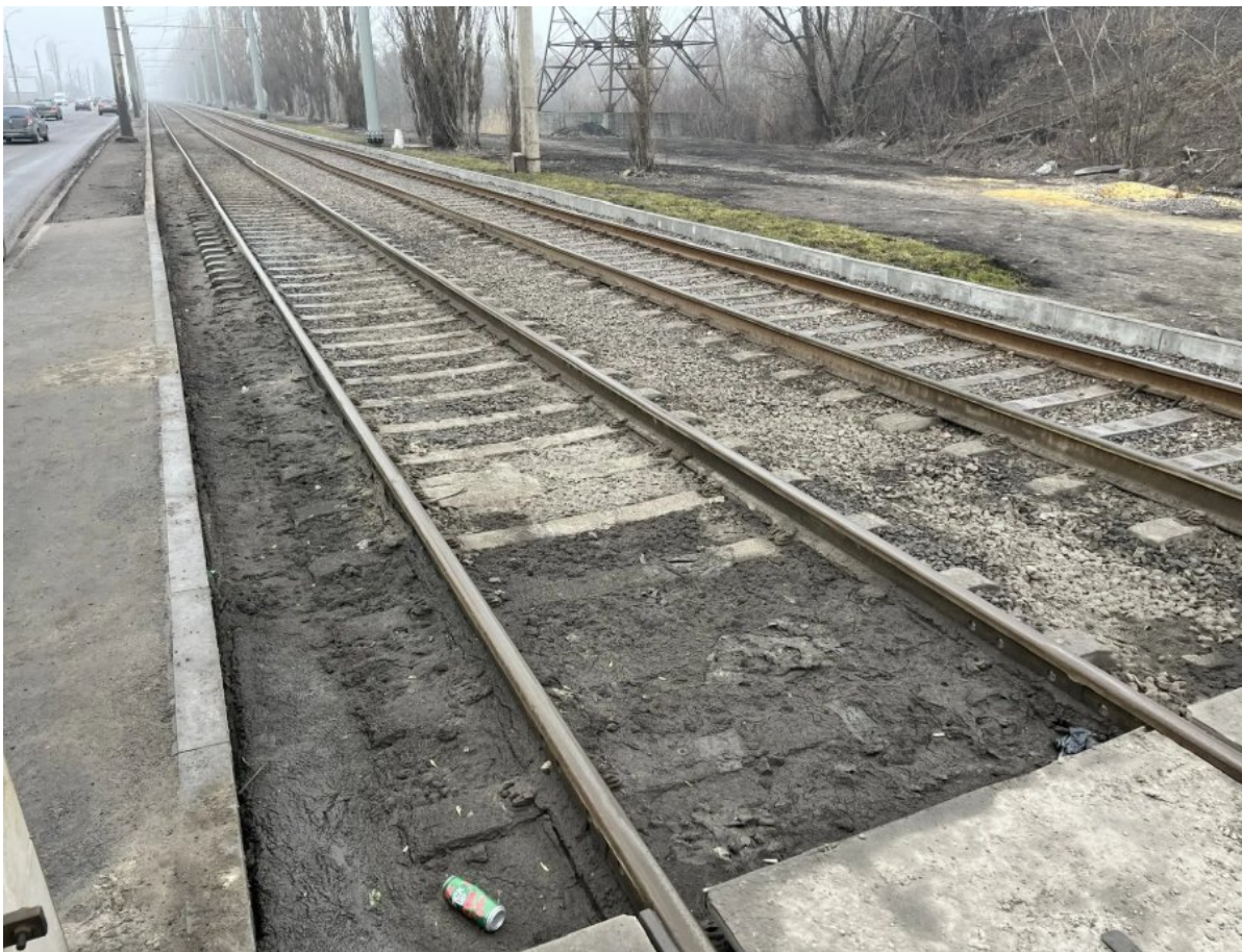
Рис.150. Остановочный пункт «ул. Речная». Засорение балластного слоя трамвайного пути.
