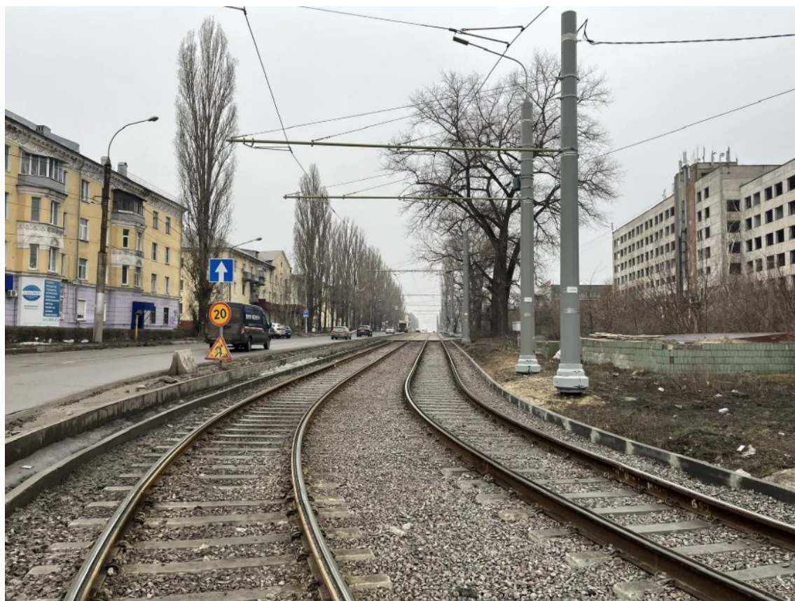
Рис. 32. Общий вид трамвайной инфраструктуры по ул. Краснозаводская.
