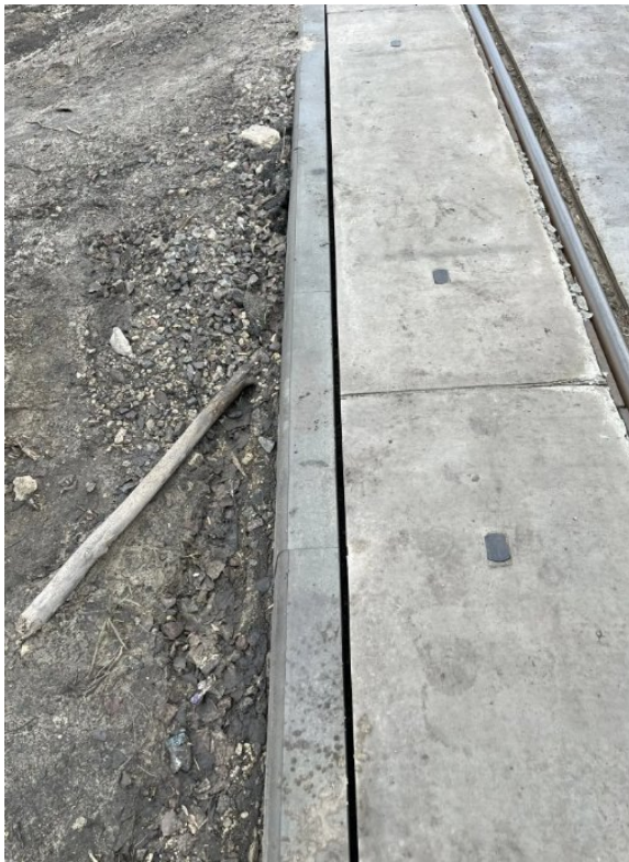
Рис.149. Остановочный пункт «ул. Речная» неплотное примыкание бортовых камней к краевой плите.
