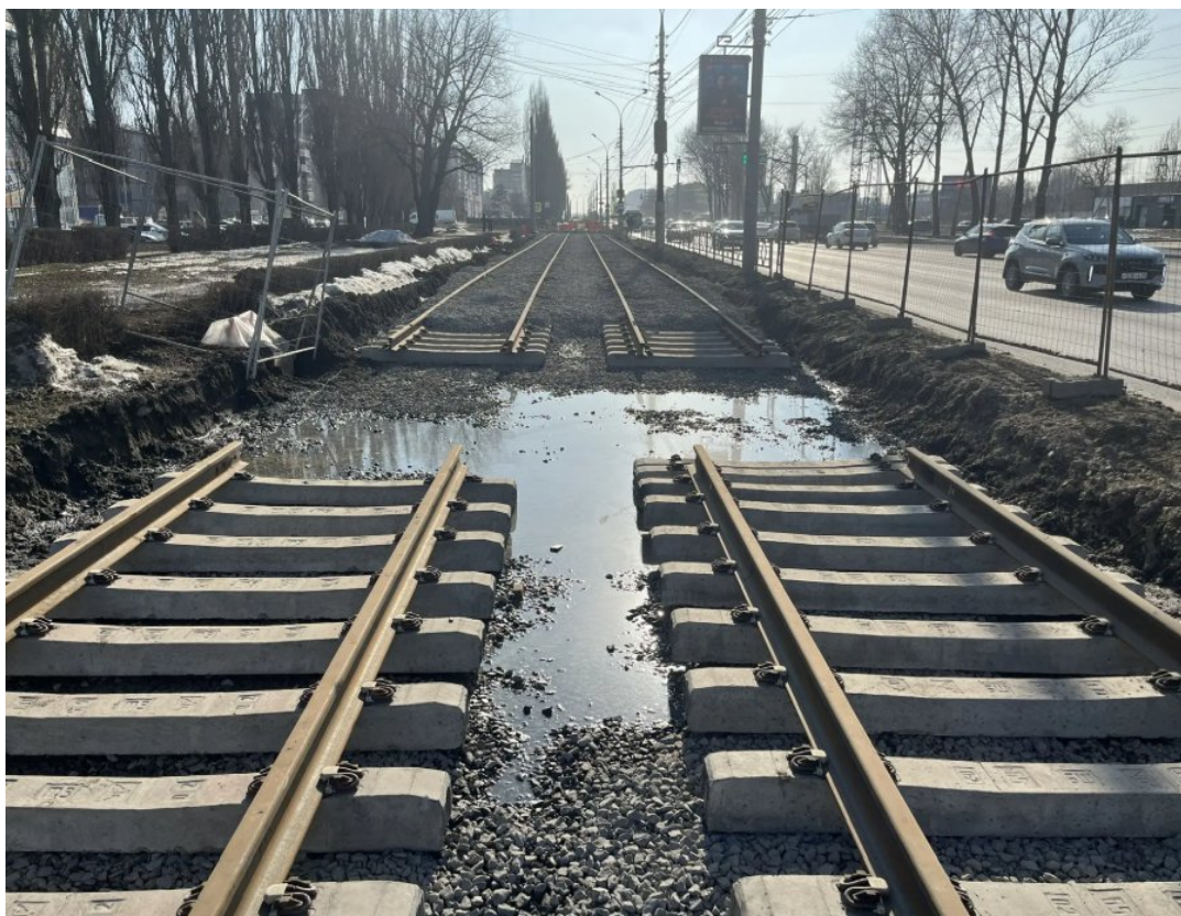
Рис. 117. Ул. Московская. Трамвайные пути визуально уложены ниже уровня дороги и прилегающей территории.
