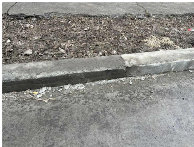
Рис. 30. Состояние бордюрного камня на остановочном пункте «Площадь Клименкова».
