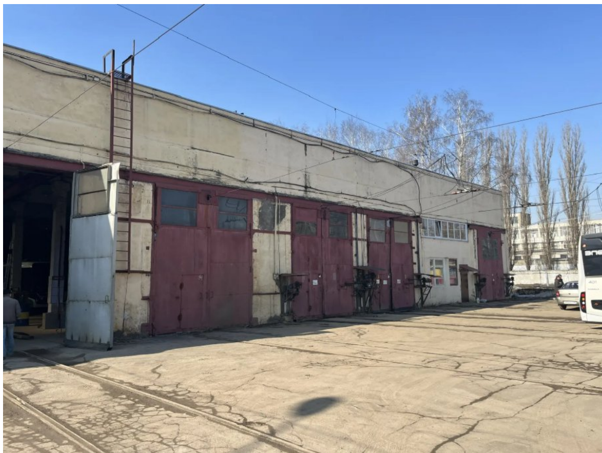
Рис. 166. Общий вид трамвайного депо на момент проведения Проверки.
