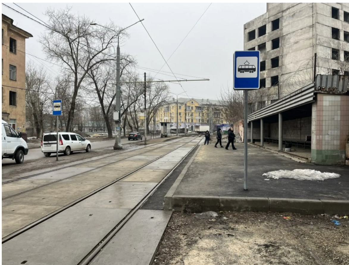
Рис. 29. Текущее состояние остановочного пункта «Площадь Клименкова».
