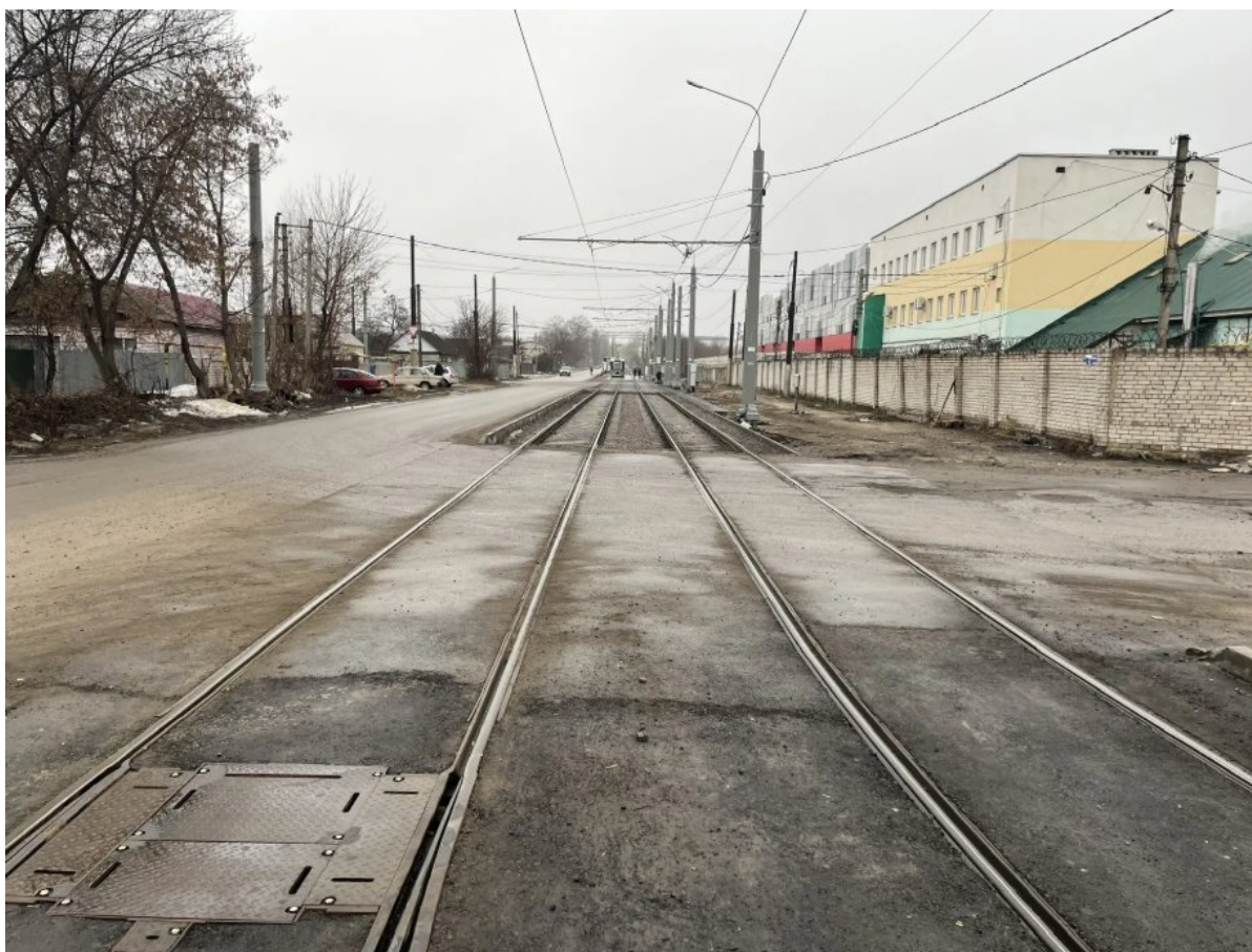
Рис. 16. Текущее состояние переезда в районе разворотной петли ул. Чехова.
