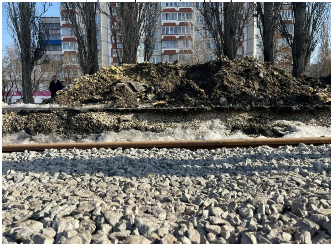
Рис. 117. Ул. Московская. Трамвайные пути визуально уложены ниже уровня дороги и прилегающей территории.
