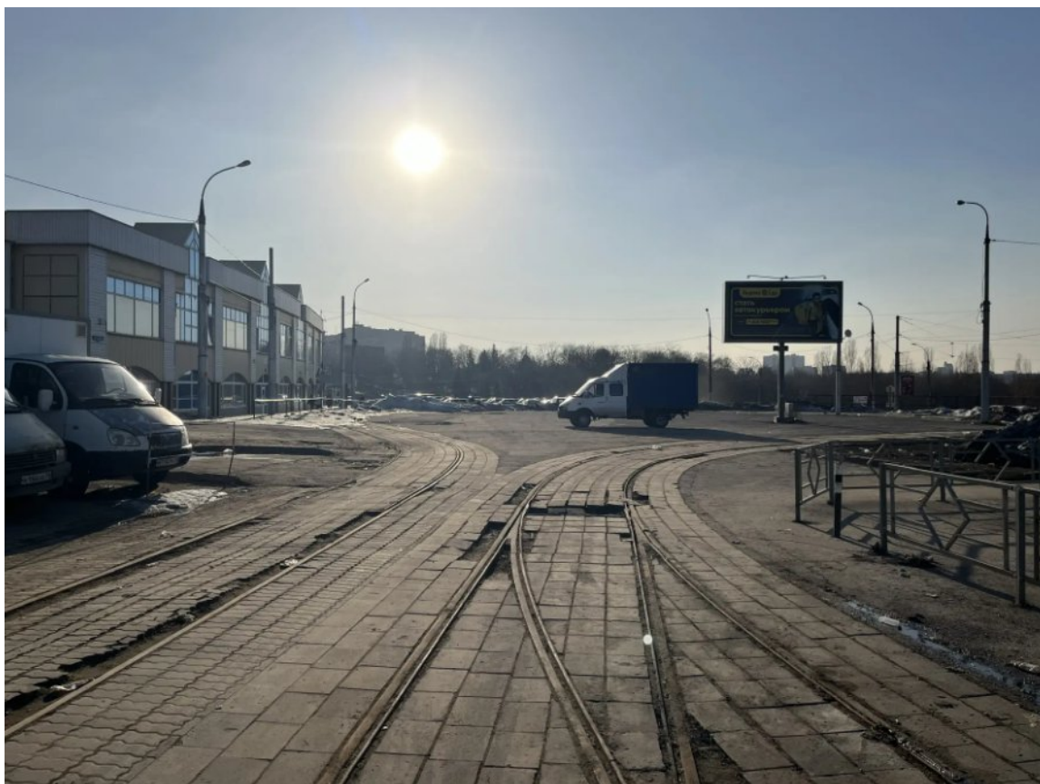
Рис.132. Демонтаж разворотной петли в районе Центрального рынка на момент проведения Проверки не осуществлён.
