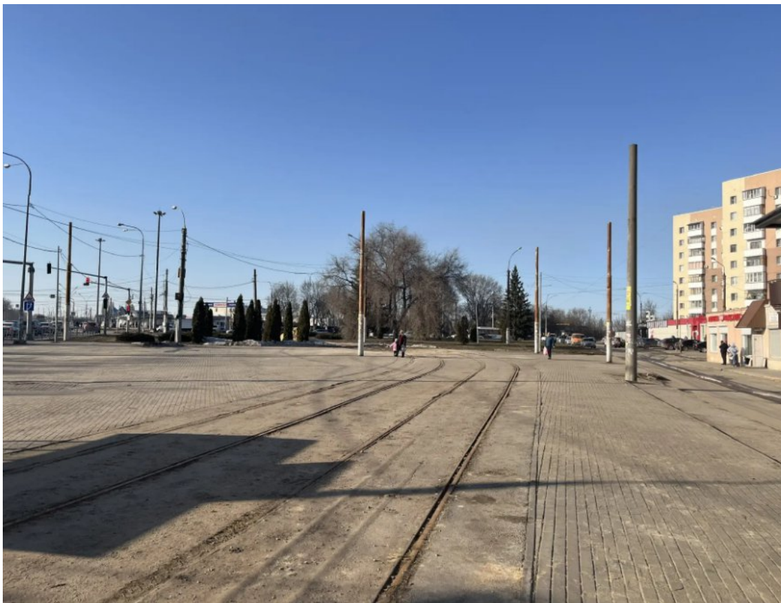
Рис.122. Остановочный пункт «Кольцо трубного завода».
