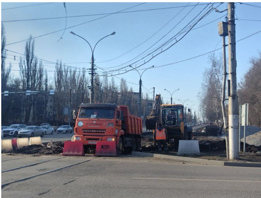
Рис. 125. Земляные работы в районе пересечения ул. Циолковского и ул. Космонавтов.
