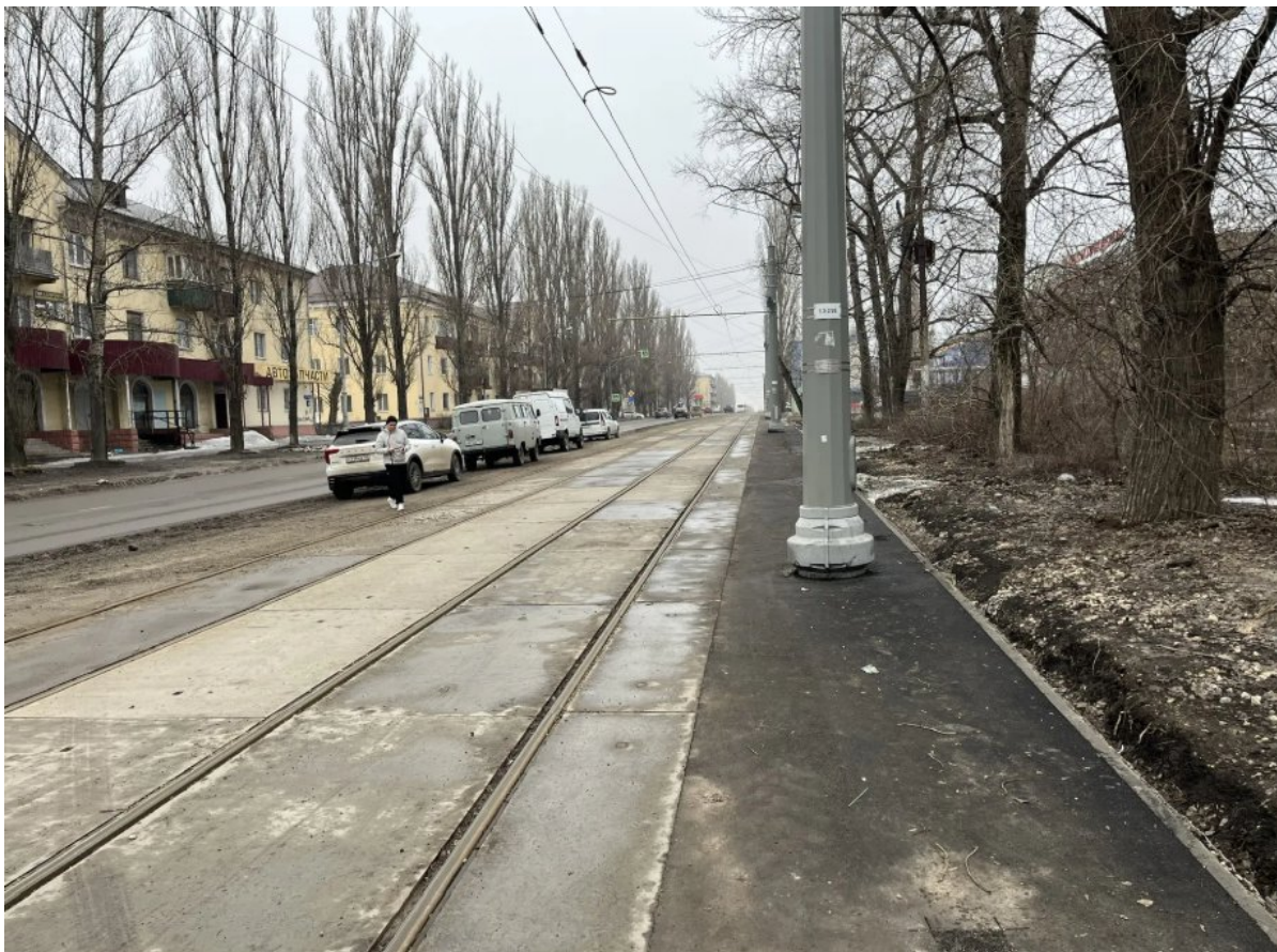
Рис. 33. Общий вид трамвайной инфраструктуры по ул. Краснозаводская
