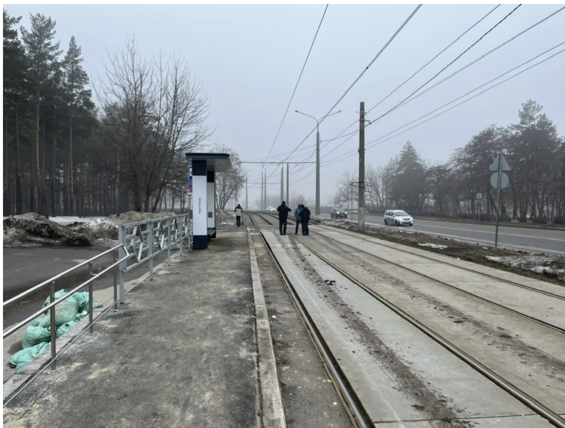
Рис. 89. Переустройство остановочной платформы и перенос павильона на остановочном пункте «Парк Победы».
