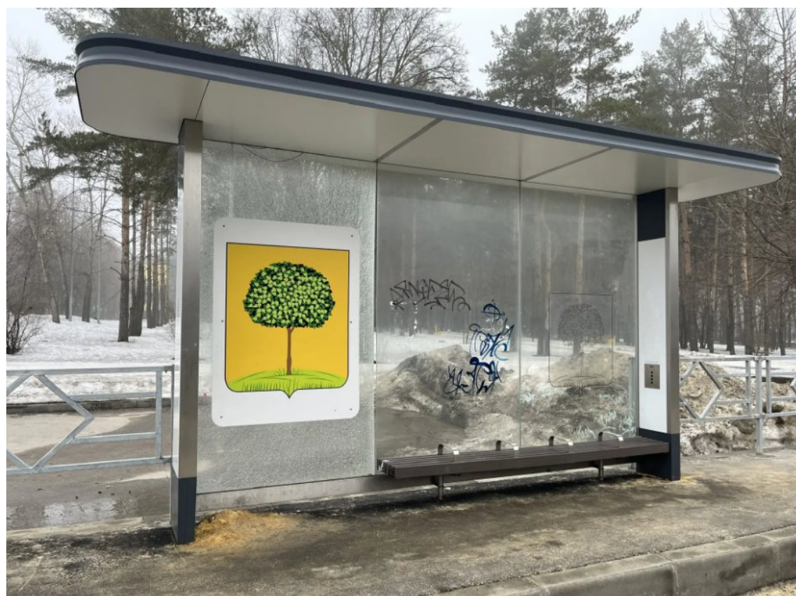
Рис. 90. Остановочный пункт «Парк Победы». Стеклопанель в сетке трещин.
