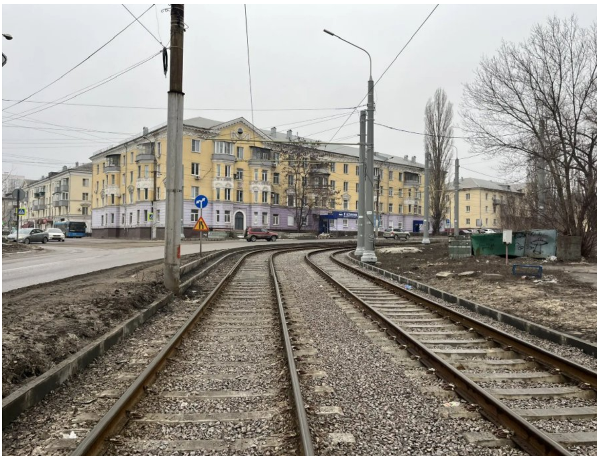
Рис. 31. Кривой участок трамвайного пути на ул. Краснозаводская
