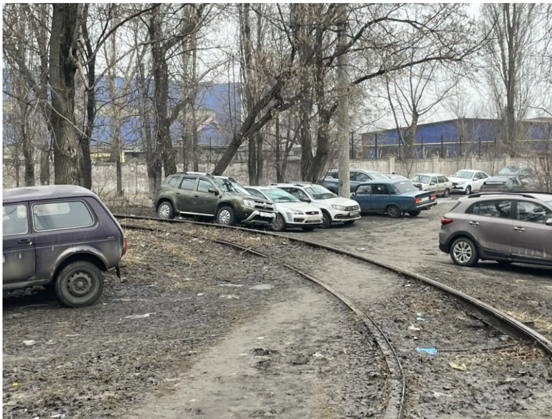
Рис.144. Разворотный круг по ул. 9 Мая. Демонтажные работы на момент проведения Проверки не начаты.
