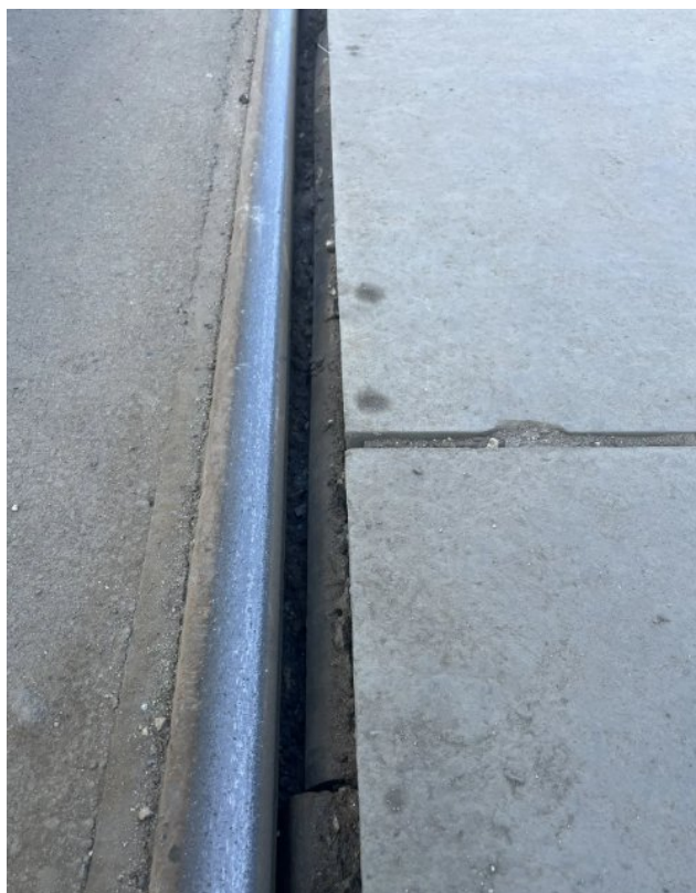
Рис. 34. Продавливание резинового уплотнителя под железобетонную плиту ул. Краснозаводская.
