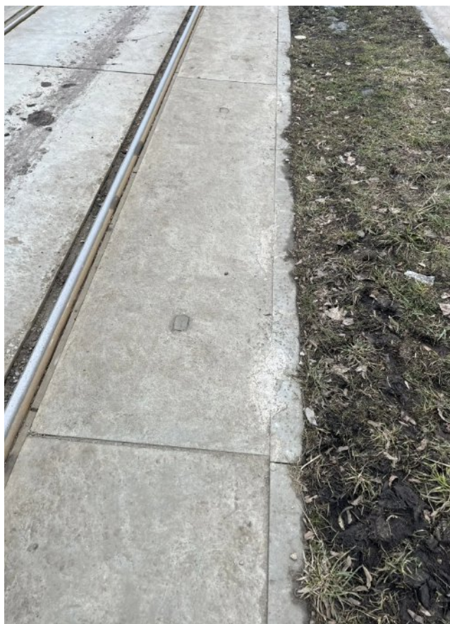
Рис. 94. Остановочный пункт «Парк Победы». Повреждение железобетонных плит и бордюрного камня.
