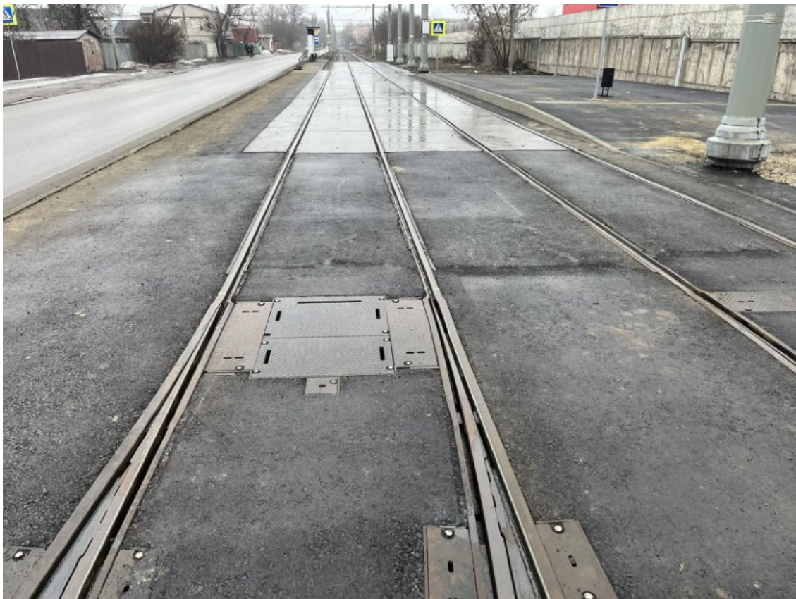
Рис. 21 Текущее состояние остановочного пункта «РСУ».
