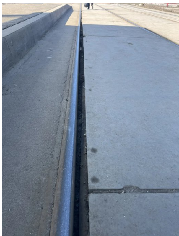
Рис. 34. Продавливание резинового уплотнителя под железобетонную плиту ул. Краснозаводская.
