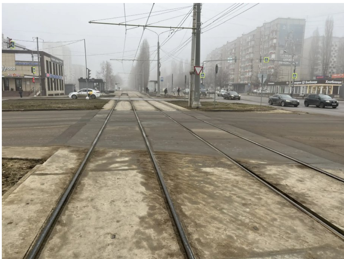
Рис. 73. Пересечение трамвайных путей с автодорогой по ул. Стаханова.
