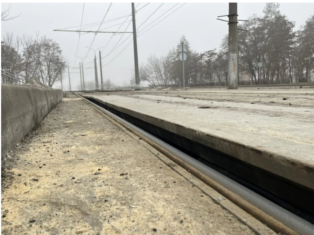
Рис. 91. Остановочный пункт «Парк Победы». Подъем железобетонных плит выше головки рельса.
