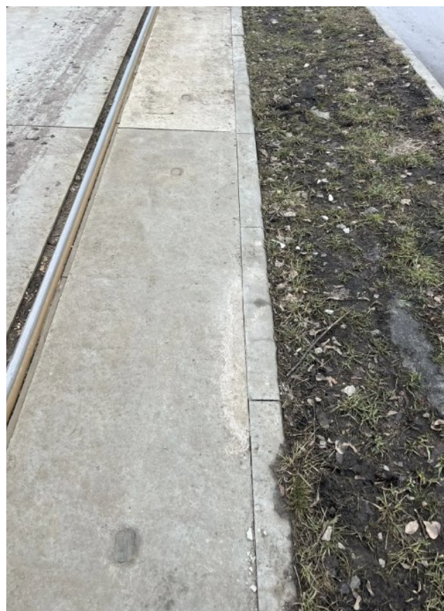
Рис. 94. Остановочный пункт «Парк Победы». Повреждение железобетонных плит и бордюрного камня.
