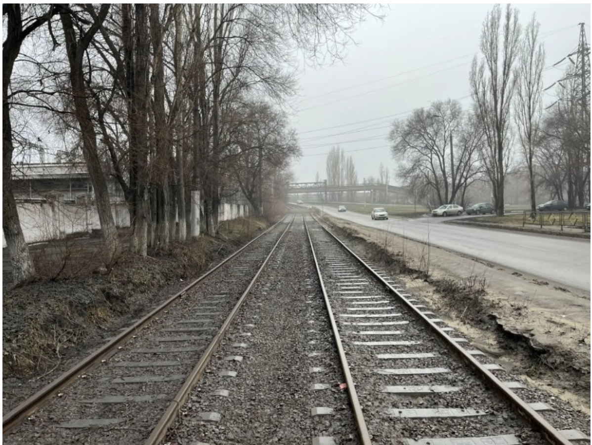
Рис.137. Общий вид новой уложенной РШР по ул. Metallургов.
