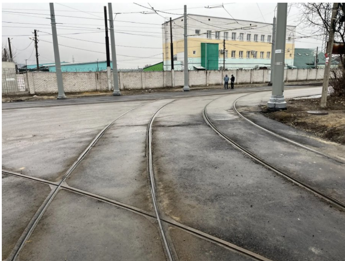
Рис. 18. Текущее состояние переезда по ул. 3 Сентября.
