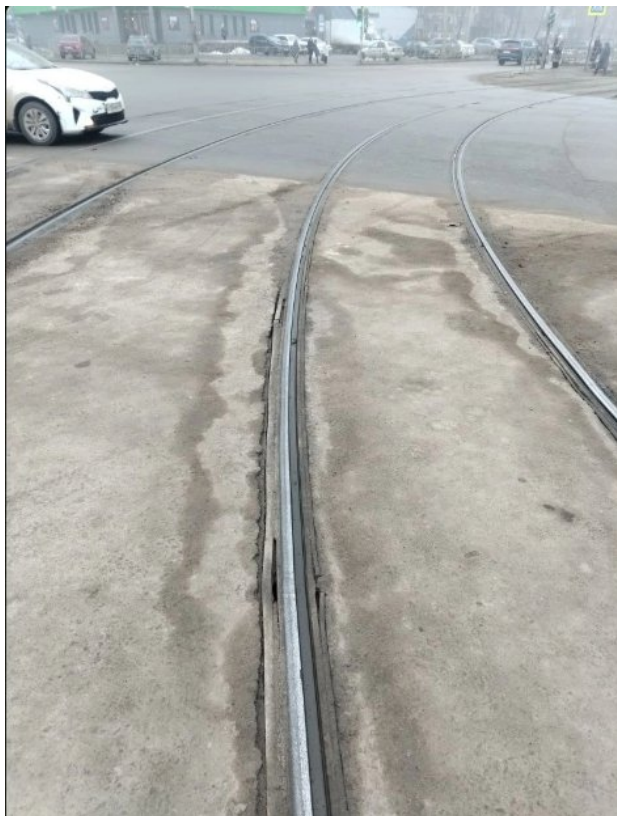
Рис. 67. Неплотное прилегание уплотнительной резинки к рельсам и разрушение асфальтового покрытия в кривой на походе к переезду через пр. 60 лет СССР.
