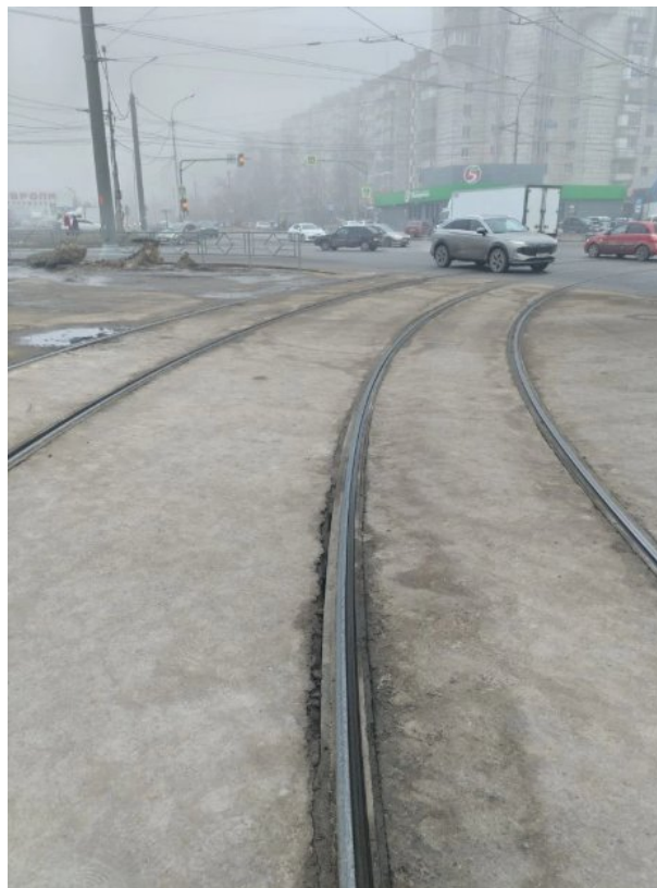
Рис. 67. Неплотное прилегание уплотнительной резинки к рельсам и разрушение асфальтового покрытия в кривой на походе к переезду через пр. 60 лет СССР.
