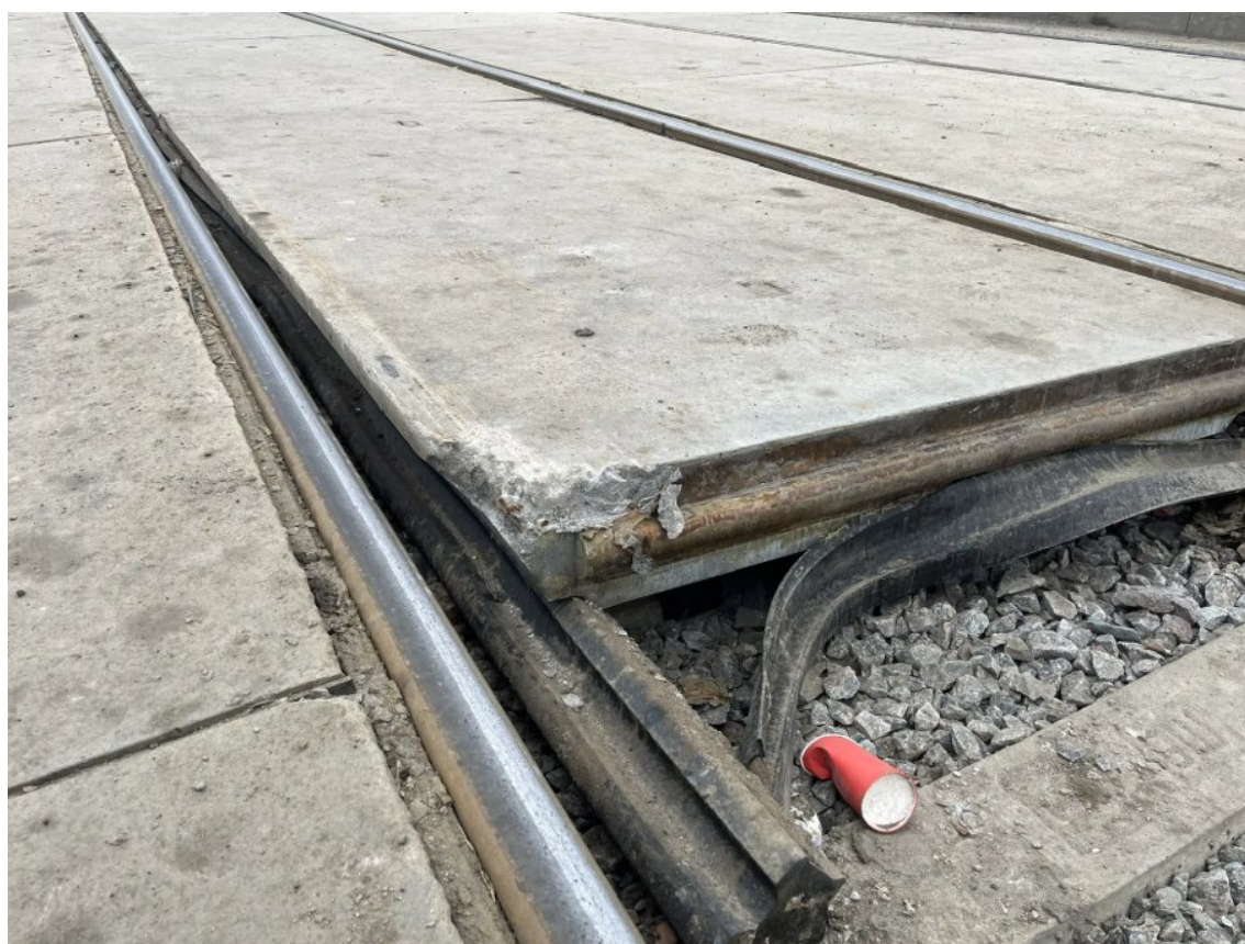
Рис. 76. Подъем железобетонных плит выше головки рельса в районе остановочного пункта «Березовая аллея».
