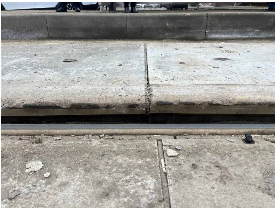
Рис. 60. Подъем железобетонных плит выше головки рельса в районе остановочного пункта «Улица Катукова».
