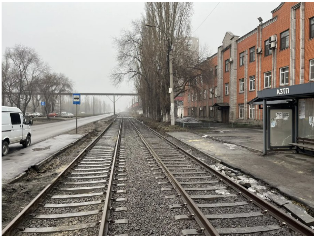
Рис.138. Общий вид новой уложенной РШР по ул. Metallургов
