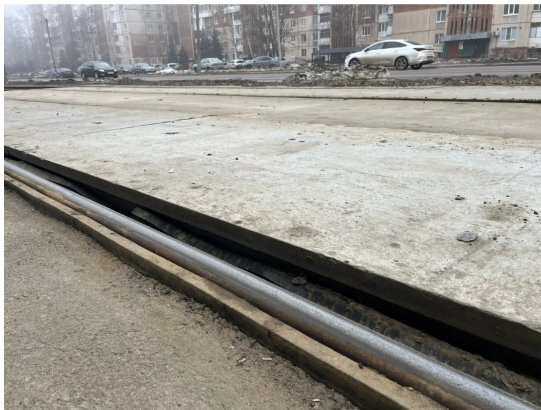
Рис. 61. Продавливание резинового уплотнителя под железобетонную плиту в районе остановочного пункта «Улица Катукова».
