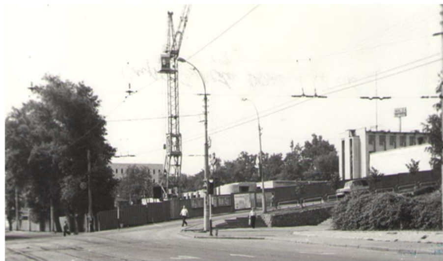
Строительство Дома Профсоюзов, 1982 год
