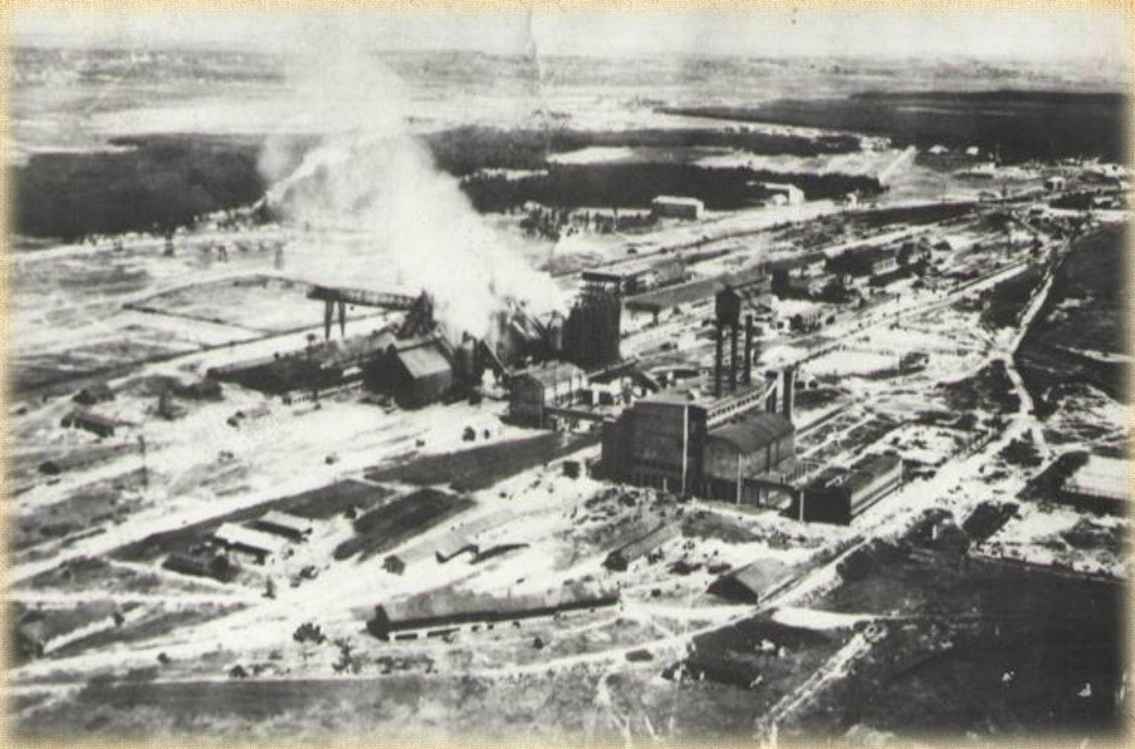
Строительство Новолипецкого металлургического завода, 1934 год
