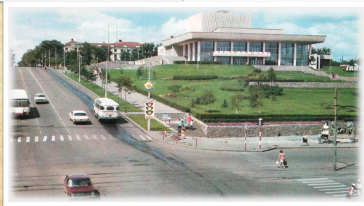
Строительство Драмтеатра, 1966-1967 годы
