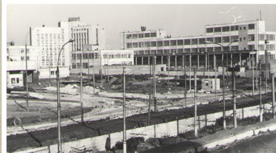
Строительство полиграфического комплекса и трамвайного депо, 1982 год
