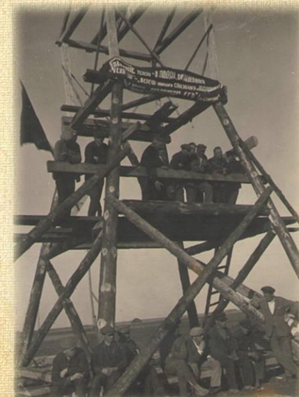
Строительство шахты, 30-е годы
