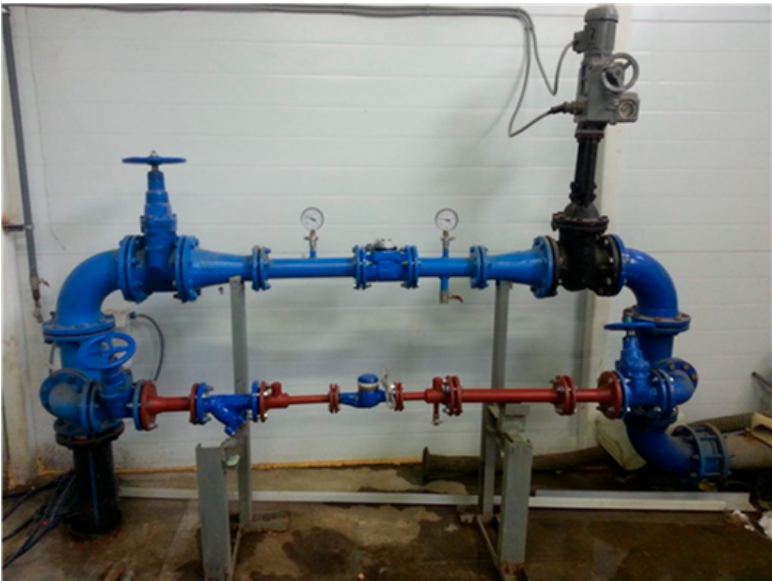
Рисунок 4-1 – Установка расходомера на водоводе
