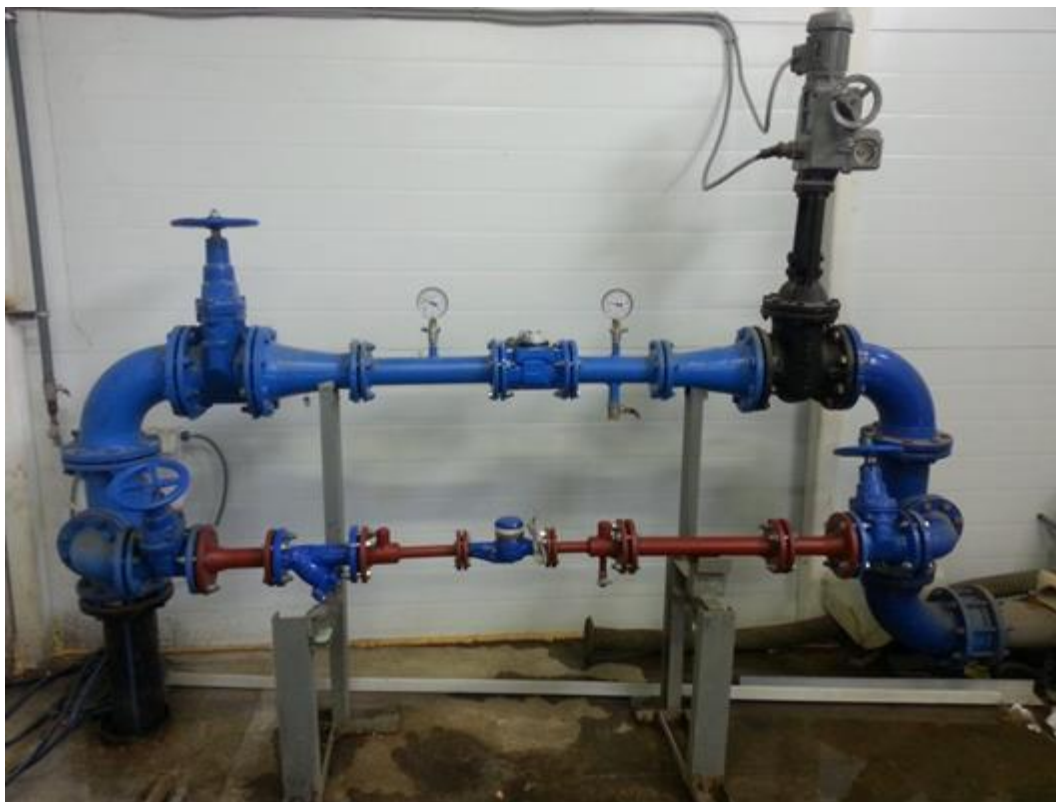
Рисунок 4-1 – Установка расходомера на водоводе
