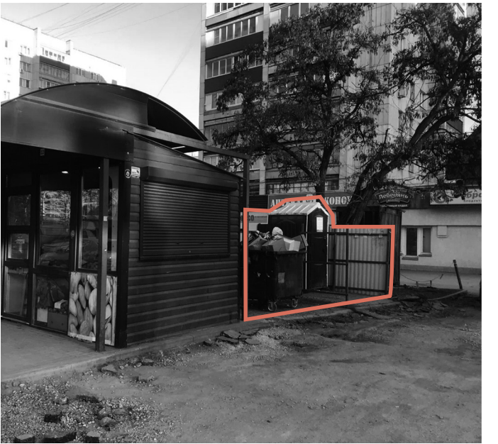
НЕУДОВЛЕТВОРИТЕЛЬНОЕ СОСТОЯНИЕ КОНТЕЙНЕРНЫХ ПЛОЩАДОК
